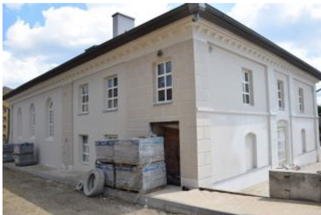
Remont budynku byłej synagogi
